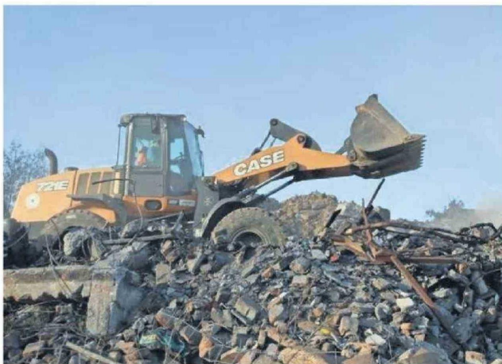
Una de las tareas más demandantes ha sido la remoción de escombros en Lirquén.
