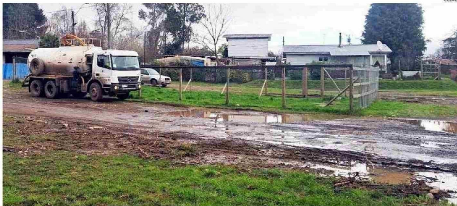
ASÍ SE VE PICHIL DIARIAMENTE: LLENO DE POZAS DE AGUAS SERVIDAS ESTANCADAS.
