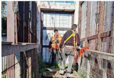
LAS TAREAS BUSCAN DETERMINAR EL REAL ESTADO DEL PUENTE.
