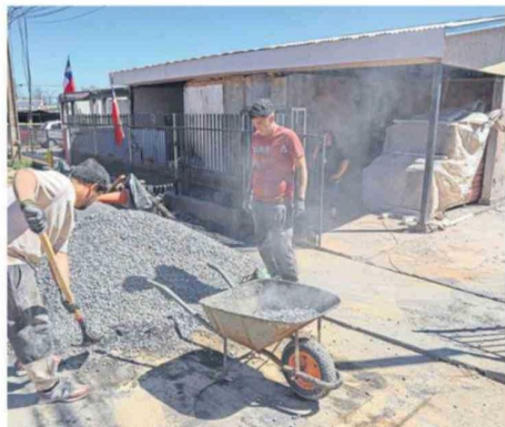
Familias iniciaron hace varias semanas la autoconstrucción.
