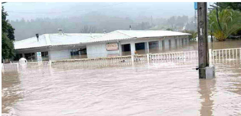
En la inundación del año 2023, el Hospital de Licantén quedó inundado.
