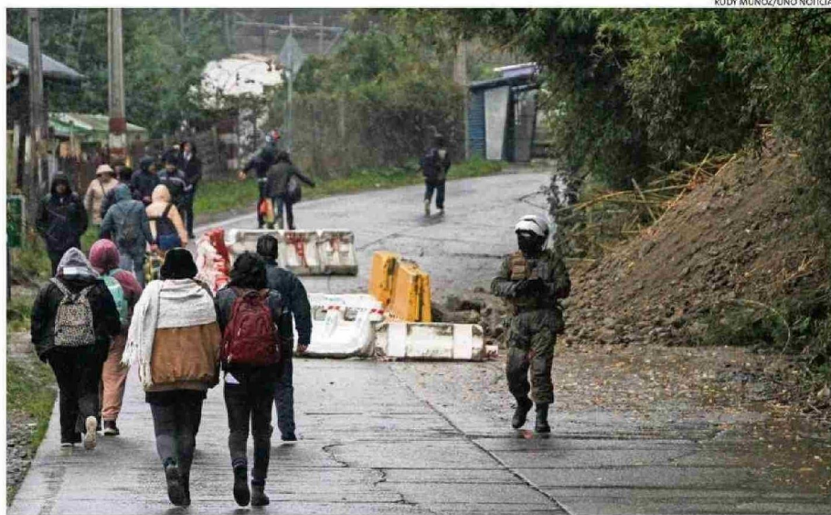
LAS REMOCIONES EN MASA, COMO LA DEL KILÓMETRO 10 DE CHINQUIHUE, SON PARTE DE LOS PELIGROS QUE EXISTEN EN PUERTO MONTT.
