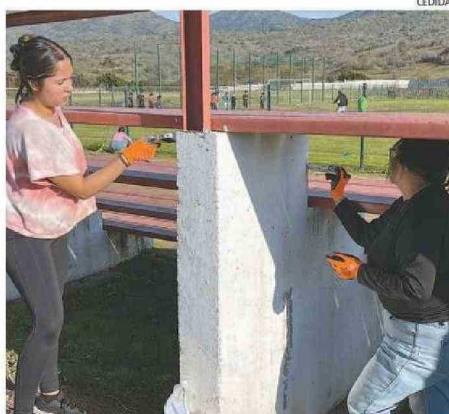
LOS TRABAJOS VOLUNTARIOS SE REALIZARON DURANTE 3 DÍAS.
