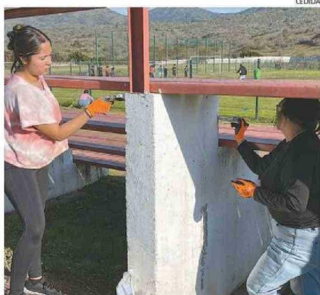
LOS TRABAJOS VOLUNTARIOS SE REALIZARON DURANTE 3 DÍAS.
