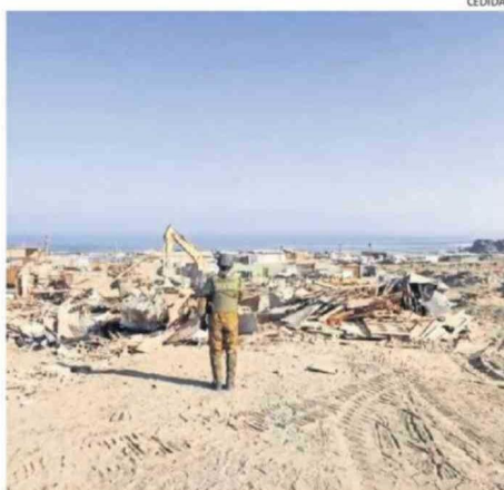
EL DESALOJO FUE EN EL CAMPAMENTO LOS PIMPINELES.
