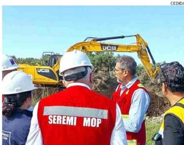
LAS AUTORIDADES INSPECCIONARON LAS OBRAS DE CORTAFUEGO.
