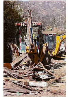
TRABAJARON EQUIPOS MUNICIPALES.
