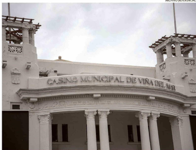
FALTA DE CIERRE FORMAL DE LA CONCESIÓN ARRIESGA EL PATRIMONIO MUNICIPAL POR $4.200 MILLONES.
