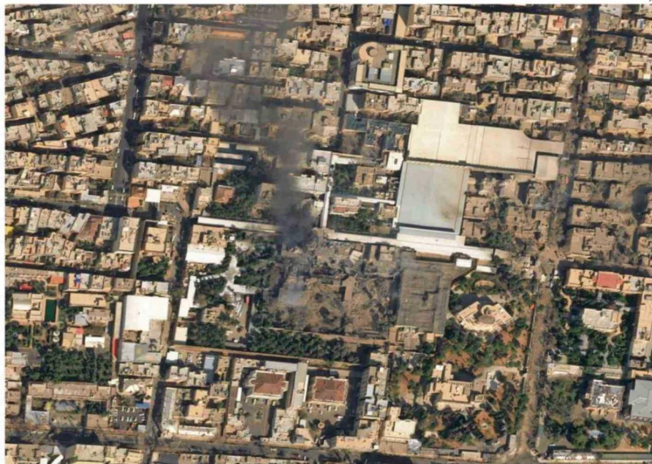
ESTA IMAGEN MUESTRA EL ESTADO DE LAS INSTALACIONES DEL LÍDER SUPREMO DE IRÁN TRAS LOS ATAQUES.
