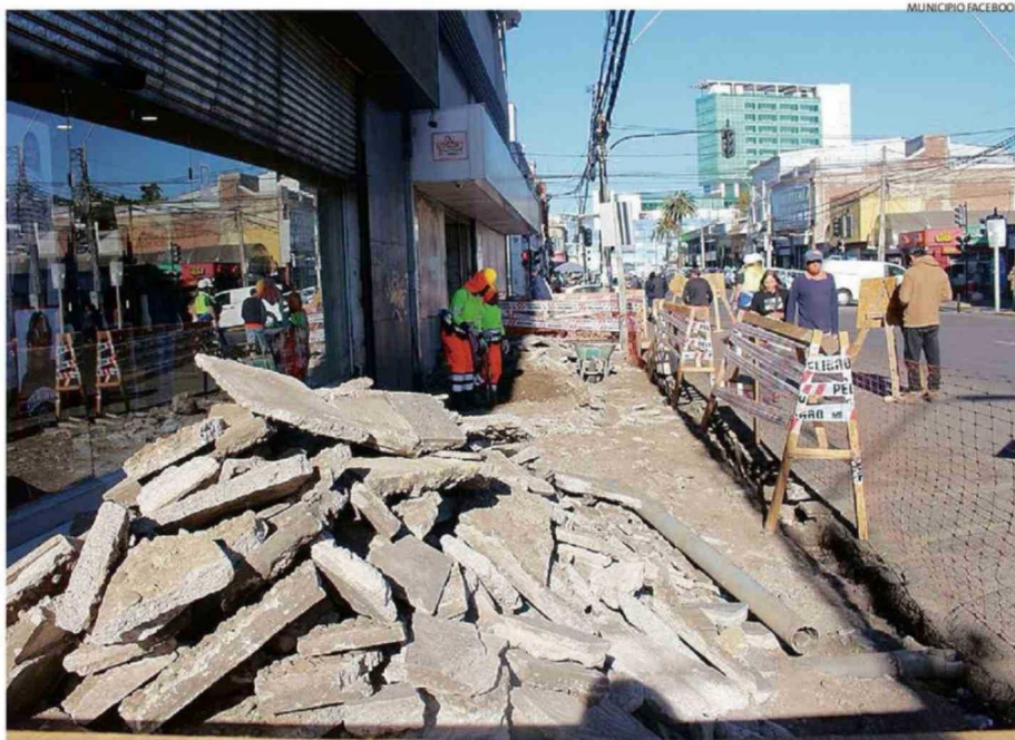
LA OBRA CONSIDERA LA VEREDA SUR Y CUENTA CON UN MONTO ADJUDICADO DE APROXIMADAMENTE 105 MILLONES DE PESOS.
