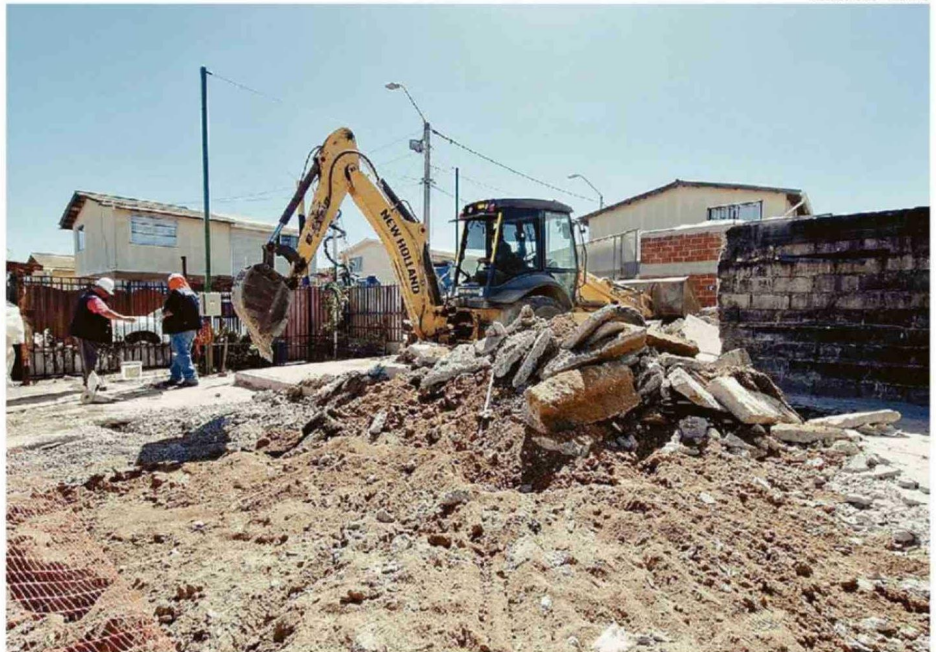
DELEGADO MILLONES. "DURANTE UN MES CONTINUARÁN LAS DEMOLICIONES". EN EL OLIVAR VECINOS ESPERAN RESULTADOS.
