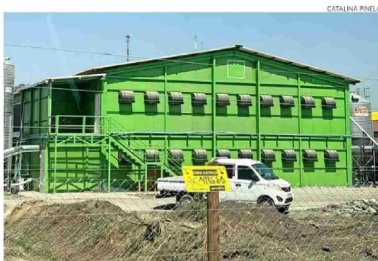
Los galpones tienen extractores para sacar el calor que producen las mismas gallinas.
