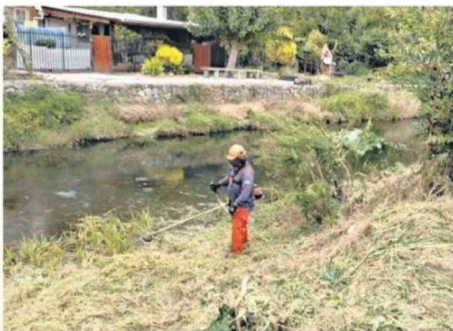
En Arauco se contrató personal para limpieza manual de canales.
