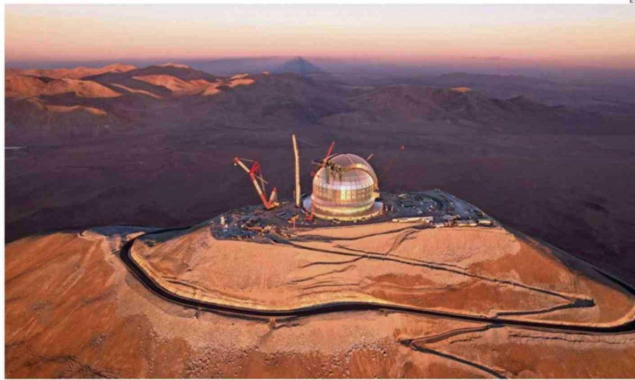
Varias grúas rodean la infraestructura científica que se construye en el Desierto de Atacama.
