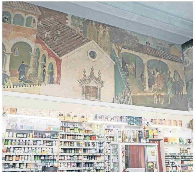
El mural data en la ex Maluje desde 1957, y el paso del tiempo ha provocado daños.
