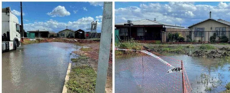
VECINOS DEBIERON ENFRENTAR calles anegadas luego de las lluvias registradas durante el fin de semana.
