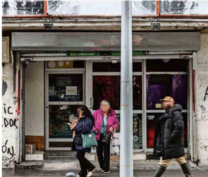
CARABINEROS ADVIRTIÓ QUE LOS ESTABLECIMIENTOS CARECEN DE VÍAS DE EVACUACIÓN.
