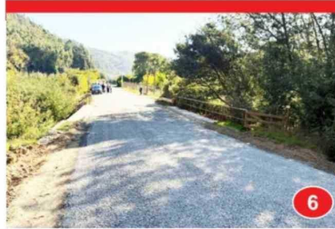
Inicio de pavimentación en sector Piedra del Lobo en Constitución
