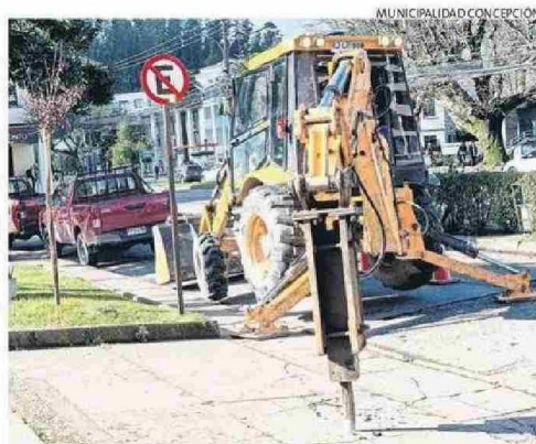
MÁQUINA INICIÓ LA REMOCIÓN DEL ANTIGUO PAVIMENTO.
