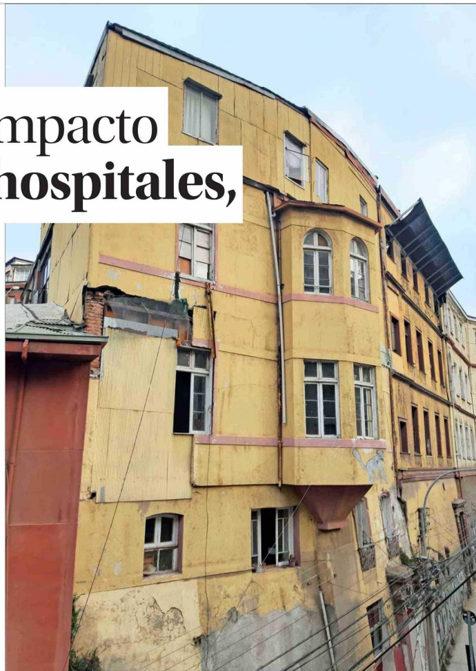
Las casas de Valparaíso construidas con la técnica del tabique-adobillo son reconocibles porque son aquellas de aspecto victoriano y que normalmente están enchapadas en lata.
