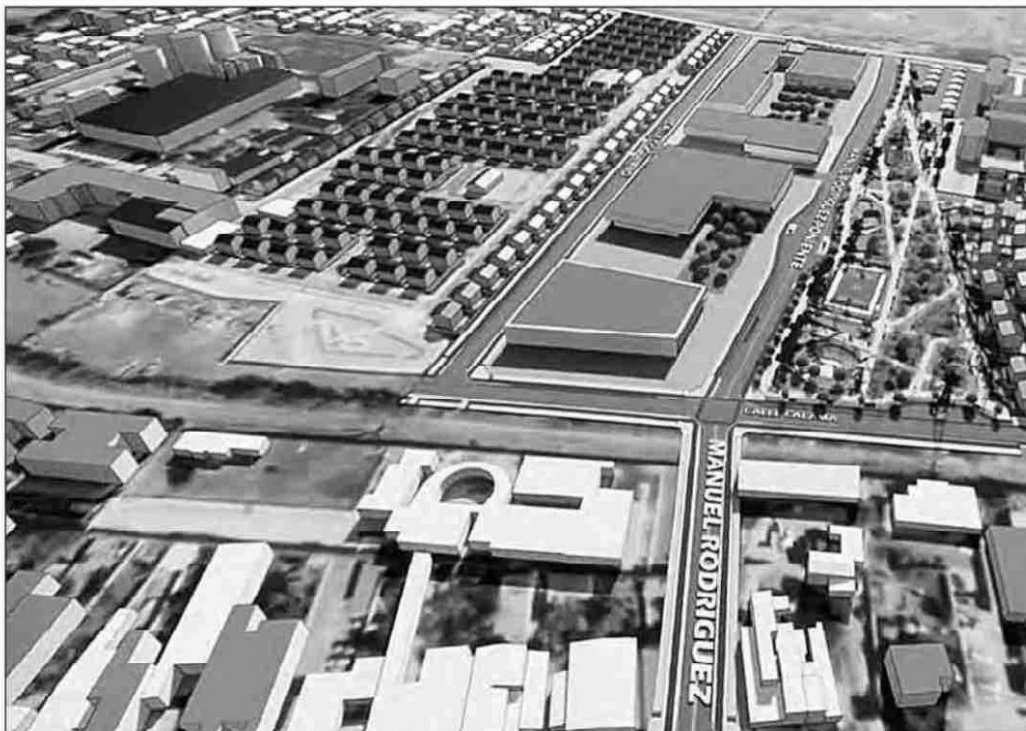
El Parque Urbano Deportivo, y otras obras cuyo comienzo está próximo, le dará un nuevo rostro a un amplio sector de Artificio.
