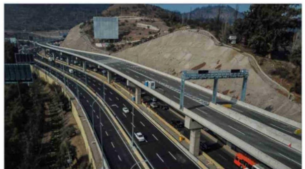
El Viaducto El Salto es un lugar olvidado en una frontera comunal que requiere intervención para mejorar su seguridad.
