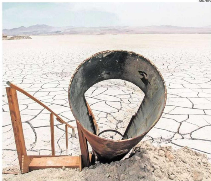
ACTUALMENTE LAS DIVISIONES CHUQUICAMATA Y MINISTRO HALES DEPOSITAN SUS RELAVES EN EL TRANQUE.
