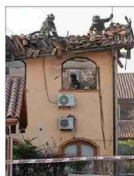
Incendio afecta a icónica casona municipal de Peñalolén, destruyendo al 25% del edificio. Se investiga posible falla eléctrica. | C 7
