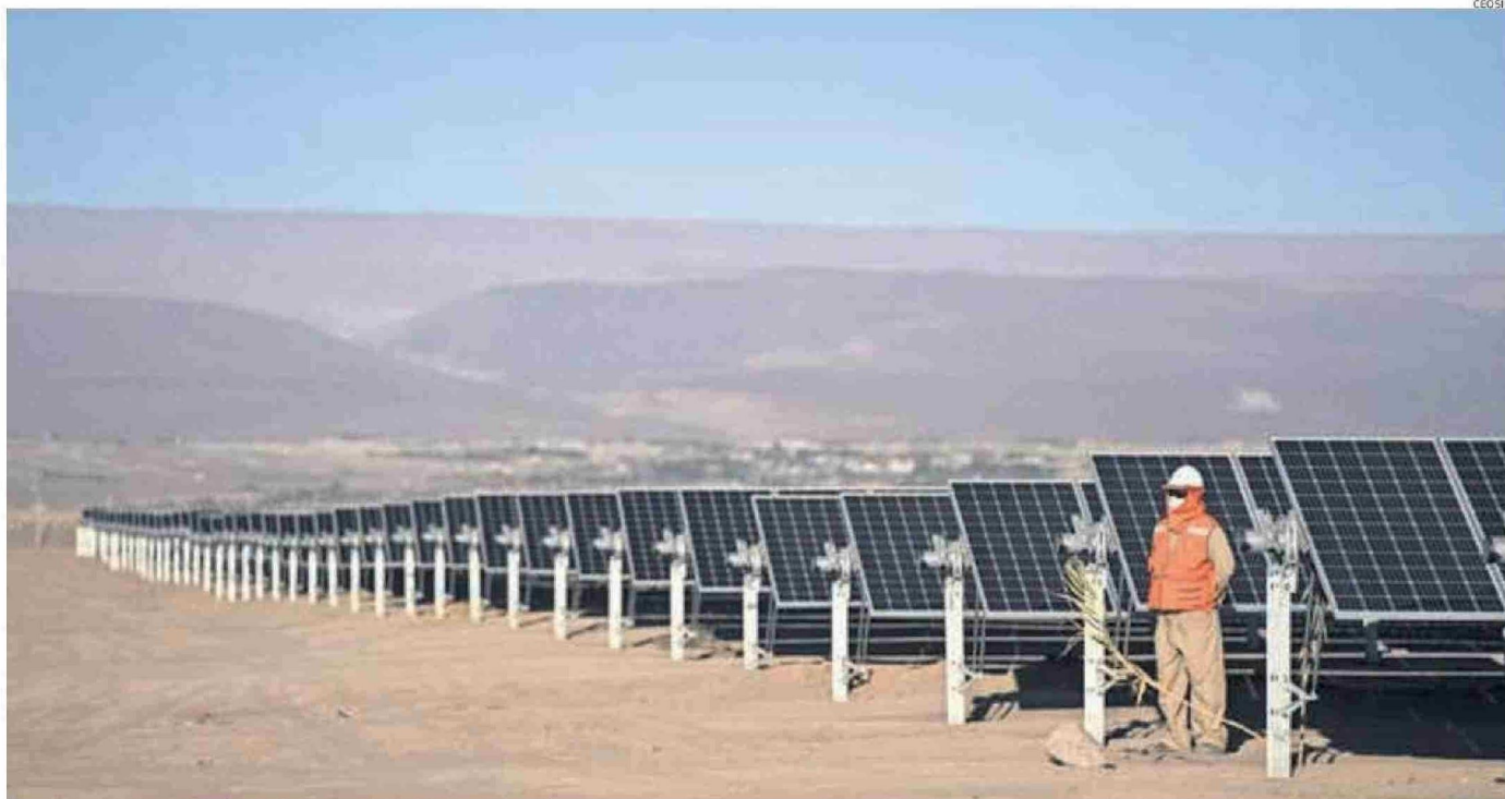
LOS PARQUES FOTOVOLTAICOS BUSCAN ABASTECER Y ROBUSTECER EL SISTEMA ELÉCTRICO DEL PAÍS.
