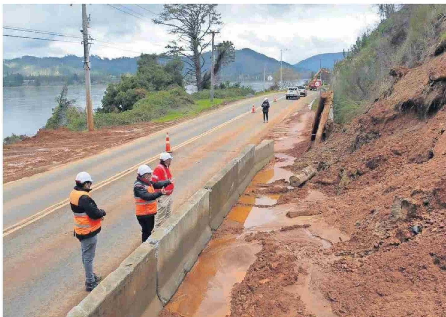
El MOP ha debido liderar trabajos en zonas de la ruta de la Madera que conecta a San Pedro de la Paz con Santa Juana.
