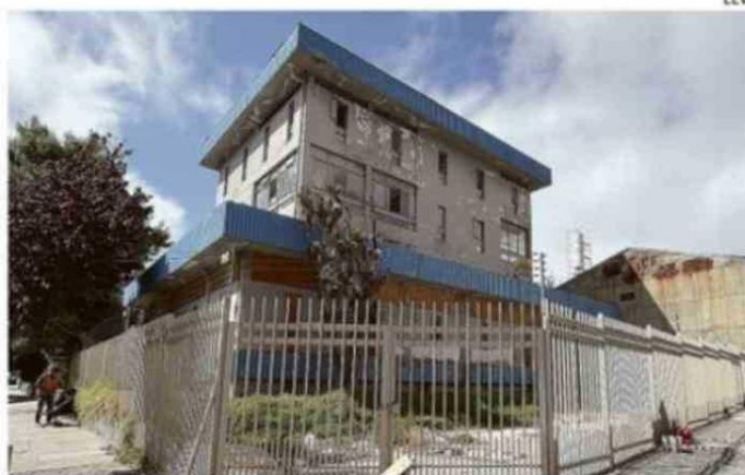
EL EDIFICIO PERMANECE ABANDONADO DESDE EL AÑO 2010.
