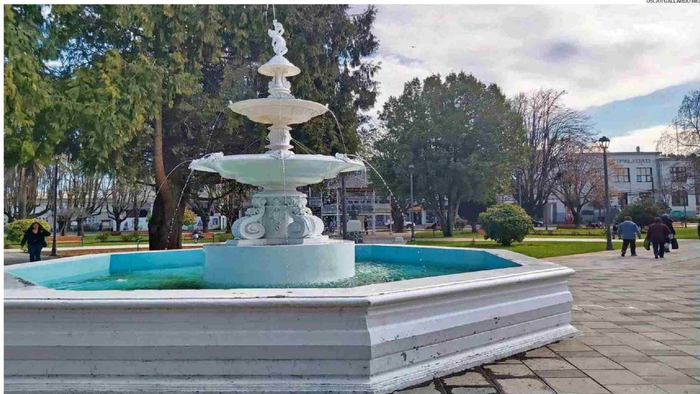
LA PILETA CENTRAL DE LA PLAZA DE LA CONCORDIA DE LA UNIÓN FUE LEVANTADA EN 70 CENTÍMETROS, PARA OPTIMIZAR EL SISTEMA DE CAPTACIÓN DE AGUAS LLUVIA HACIA EL PERÍMETRO DEL ÁREA VERDE.
