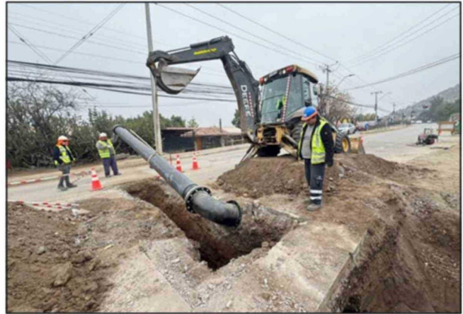
Esva termina renovación de redes sanitarias en Los Andes.
