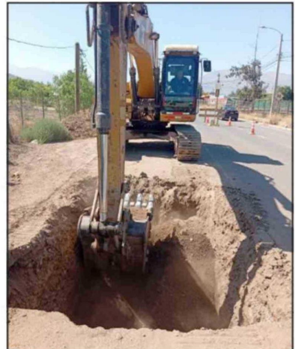
Obras tuvieron inversión superior a los $1.300 millones.
