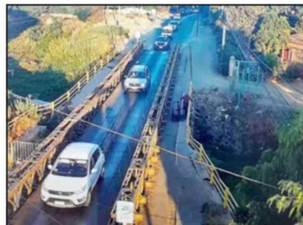
Municipio de Llay Llay busca apurar los trabajos de diseño del nuevo Puente Merino.
