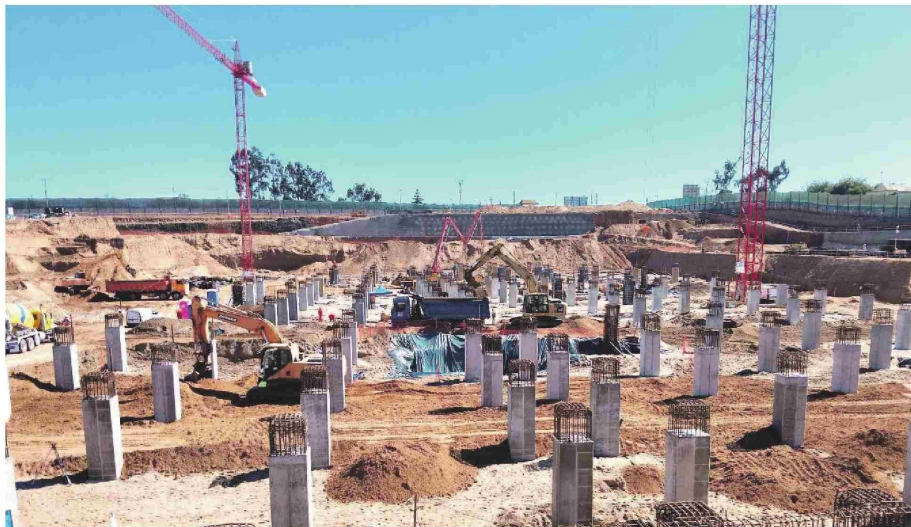
Los trabajos de excavación masiva estarían ya casi concluidos.
