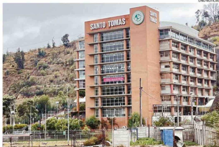
LA UNIVERSIDAD ESTÁ PREPARANDO LA INSTALACIÓN DE TORNIQUETES EN LA SEDE DE LIMONARES.
