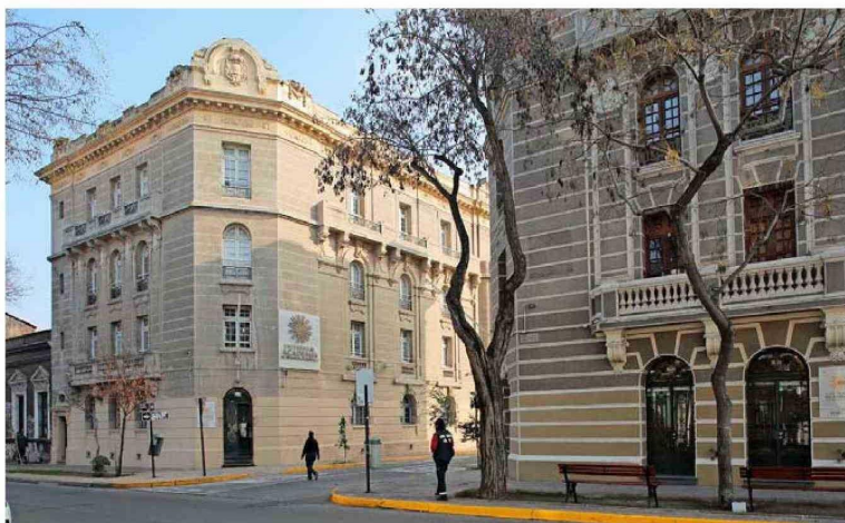
En el ingreso sur, por calle Salvador Sanfuentes, se encuentran estos dos edificios pertenecientes a la Academia de Humanismo Cristiano.
