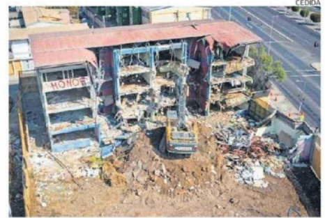
PARTE DE LAS OBRAS DE DEMOLICIÓN DEL EXEDIFICIO INSTITUCIONAL.
