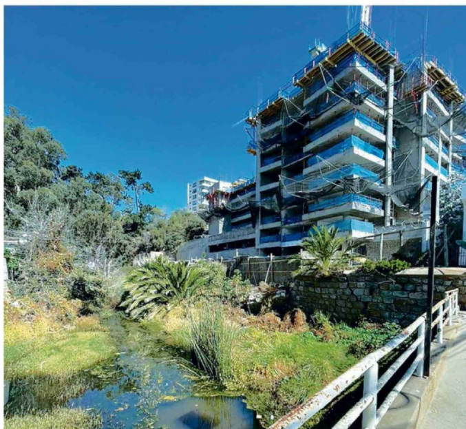
EL EDIFICIO ESTÁ EN PLENA FASE DE CONSTRUCCIÓN.
