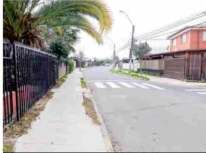
Pavimentación participativa Sol de Septiembre Primera Etapa, finalizó exitosamente.
