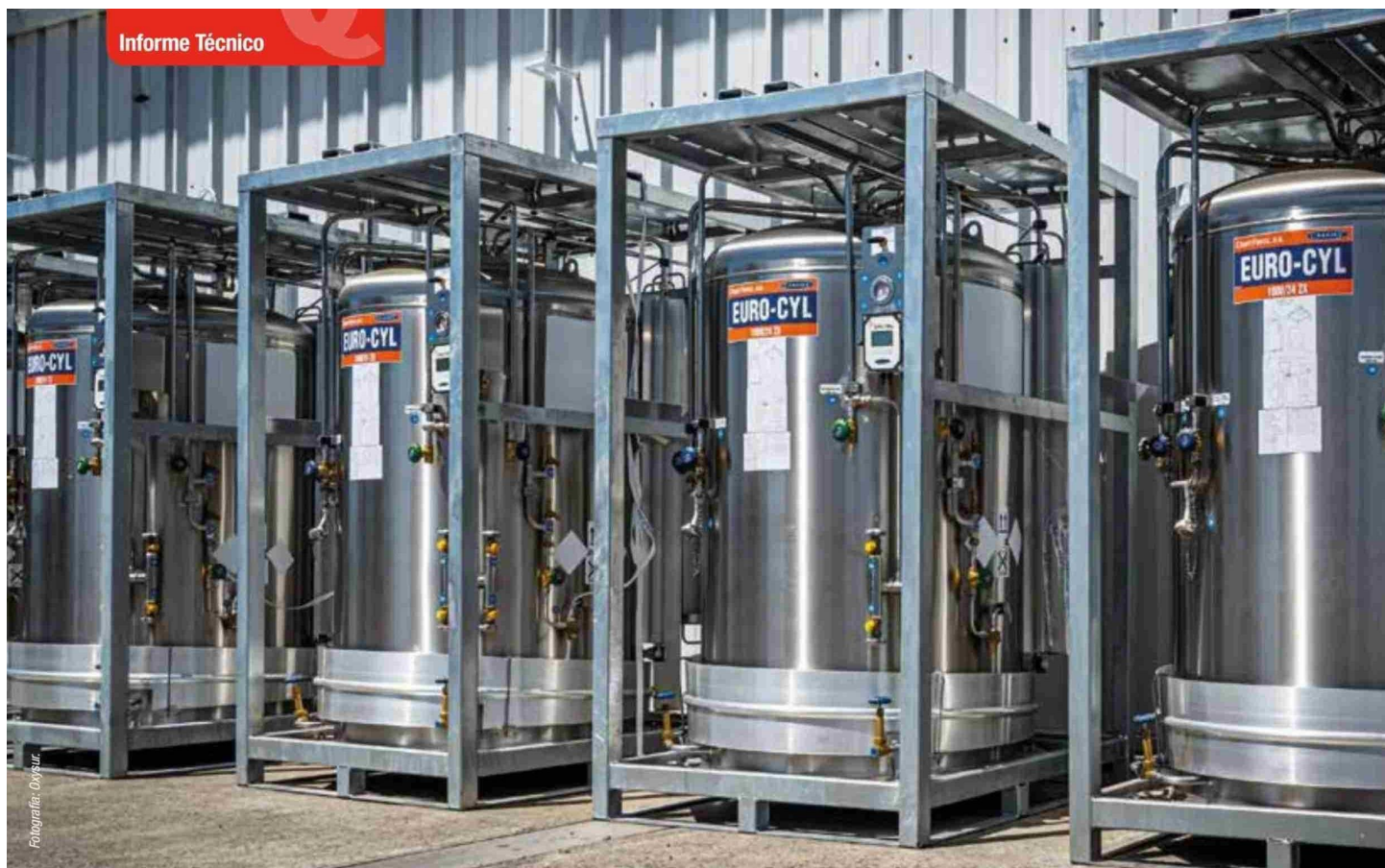
Estanque de Oxígeno líquido (LOX) de Oxysur.
