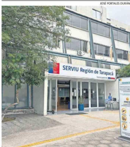
HOY CORROBORARÁN SI SUBSANARON LAS DEFICIENCIAS DETECTADAS.
