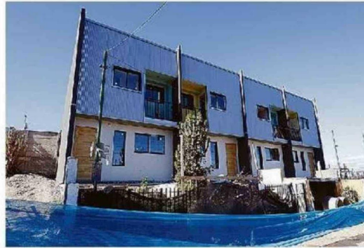
MINISTRO PODUJE INSISTE EN DEMOLER VIVIENDAS CON DEFICIENCIAS.
