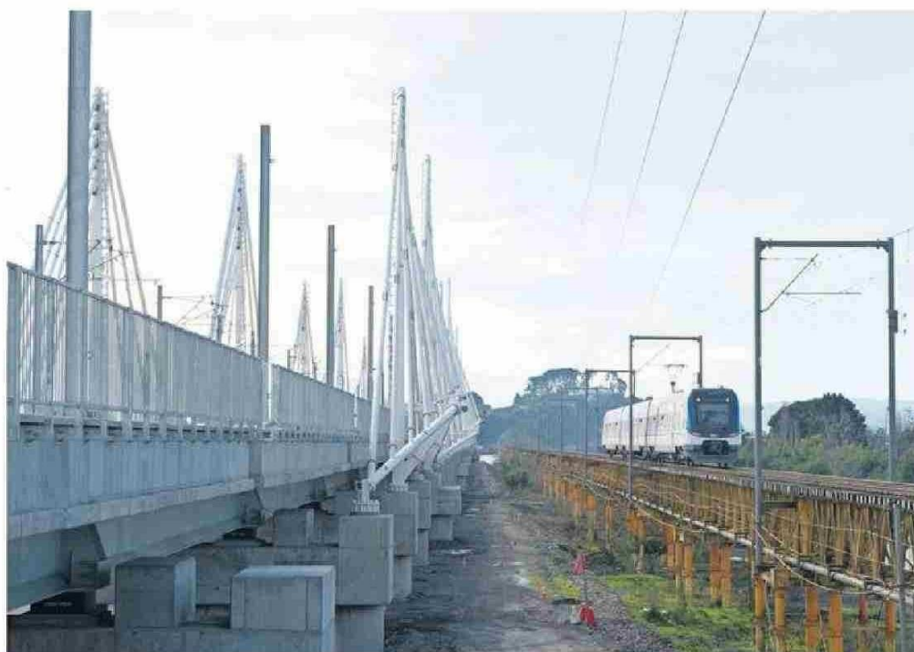
El nuevo puente Ferroviario se construyó a un costado del antiguo viaducto que data de 1889.
