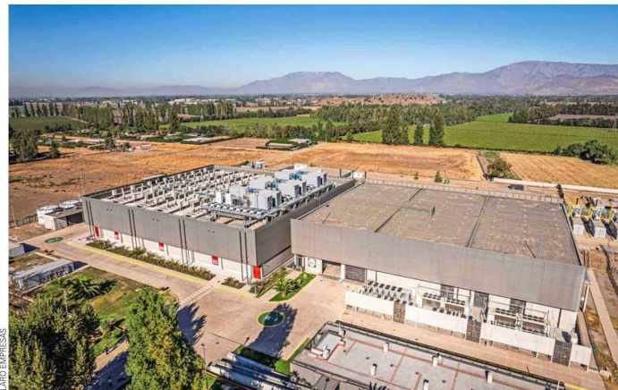
El data center Claro Liray cuenta con un modelo de operación proactiva.
