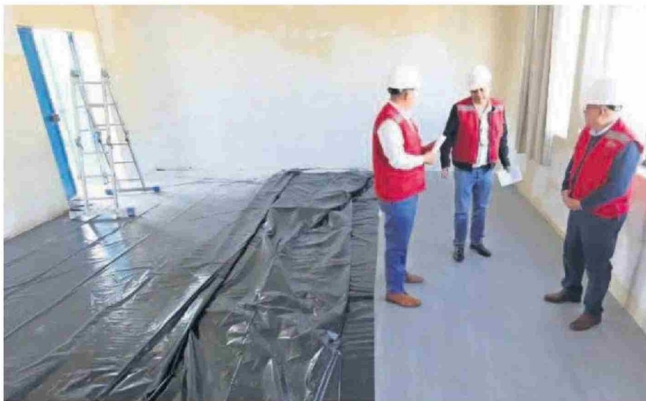
AUTORIDADES DE LA CMDs REALIZARON UNA INSPECCIÓN DE LAS OBRAS.
