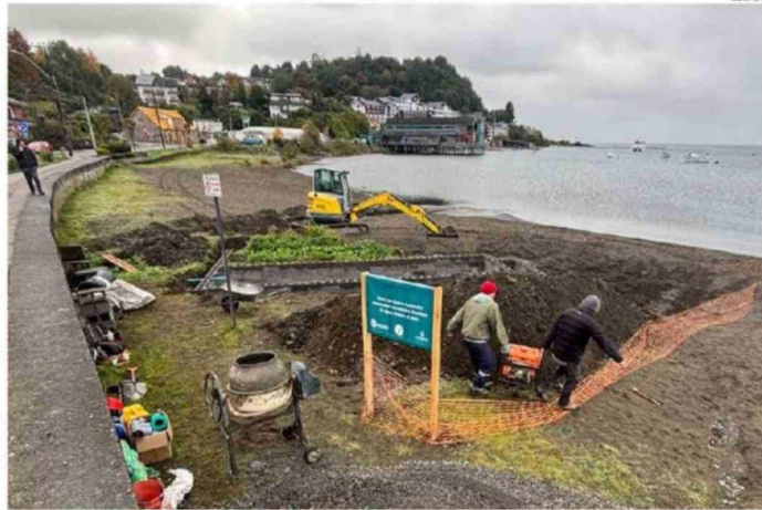
EL LUNES 11 DE MAYO COMENZARON LAS OBRAS PARA HABILITAR EL PILOTO DE HUMEDAL FITODEPURADOR.
