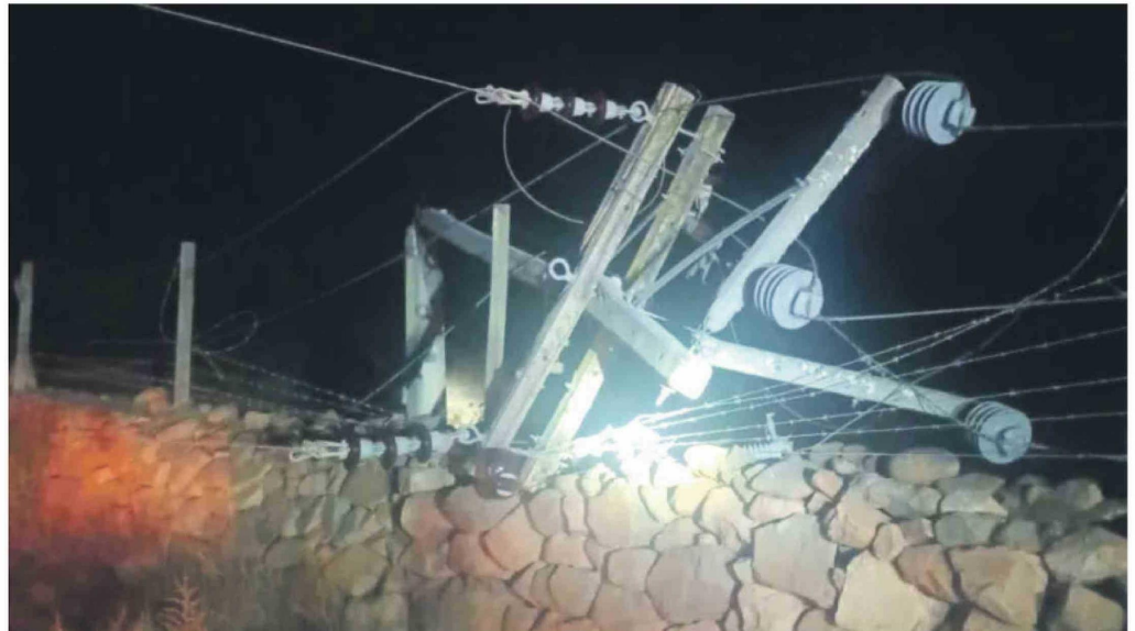
Seis postes derribados y 1.500 metros de cable sustraído dejó un nuevo robo en Llanos de Tabalí, afectando a sectores rurales de Ovalle.
