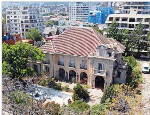
HISTORIA. — La casona hecha de hormigón armado fue edificada entre 1926 y 1929 por encargo de la familia Cousiño. Luego, la compró el empresario Vicente Martínez, cuya hija se casó con Manuel Losada.
