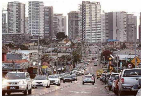
LAOS TRABAJOS DE PAVIMENTACIÓN SE INICIARÁN EL SEGUNDO SEMESTRE.
